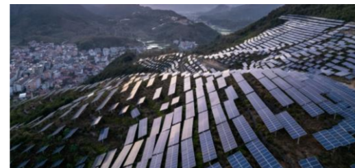
山肌に設置されたソーラーパネル
